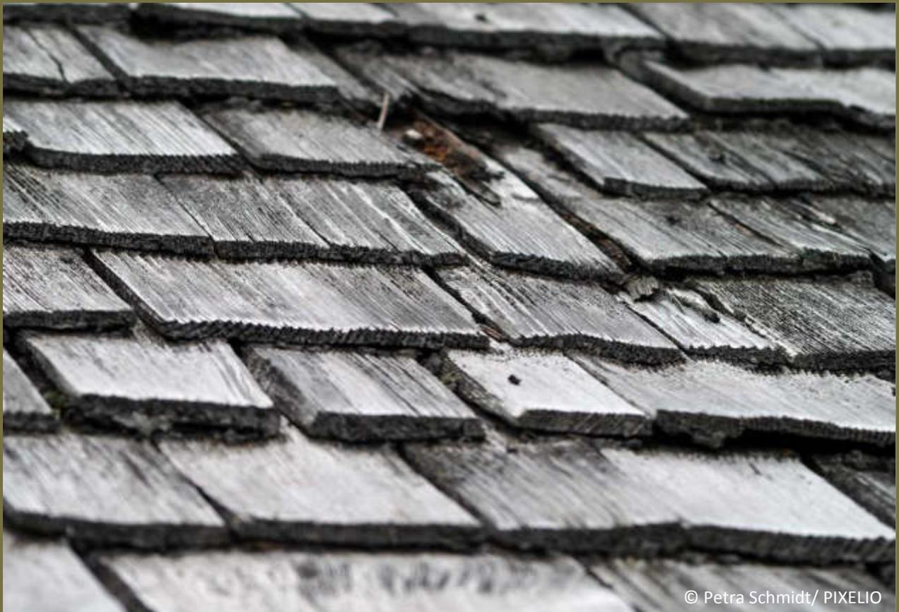
Schindeln sind eine alte Form der Dachdeckung. Besonders die Dächer der traditionellen Gommer Gebäuden sind mit einheimischen Lärchenschindeln eingedeckt. Die Herstellung der Schindeln erfolgt nach einer langen und alten Tradition.
