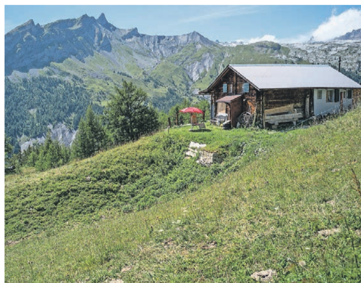
Wie weiter? Eine umgebaute Hütte ausserhalb der Bauzone bei Dorbagnon, Gemeinde Savièse.
